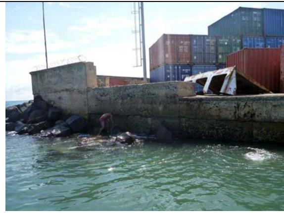
Le câble est en cours de démontage
