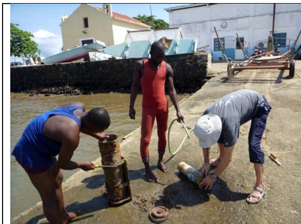
Nettoyage de la structure...
