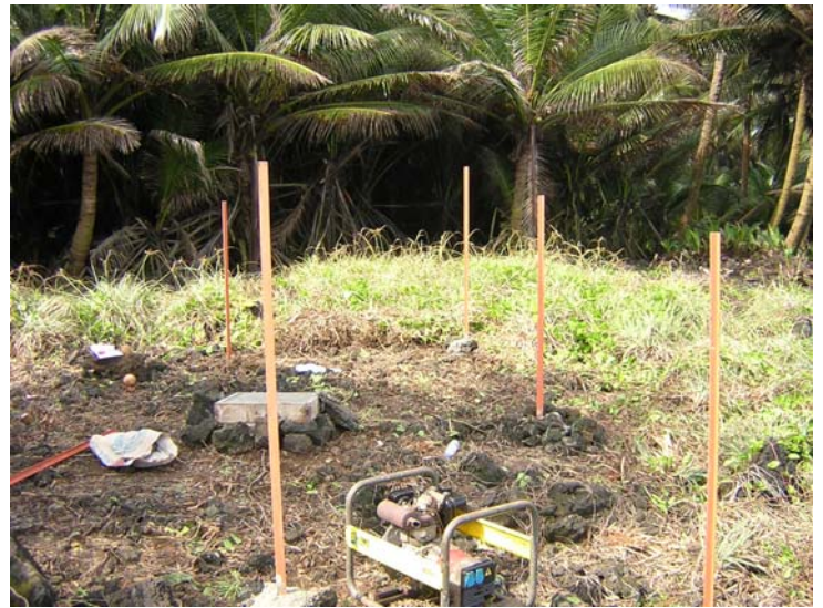
Photos 4 : A gauche : Arrivée sur le site choisi pour l'implantation de la station météorologique. A droite : début des travaux : dalle en béton pour le support de la station et poteaux pour le grillage de protection. Au premier plan, la groupe électrogène transporté sur place.
