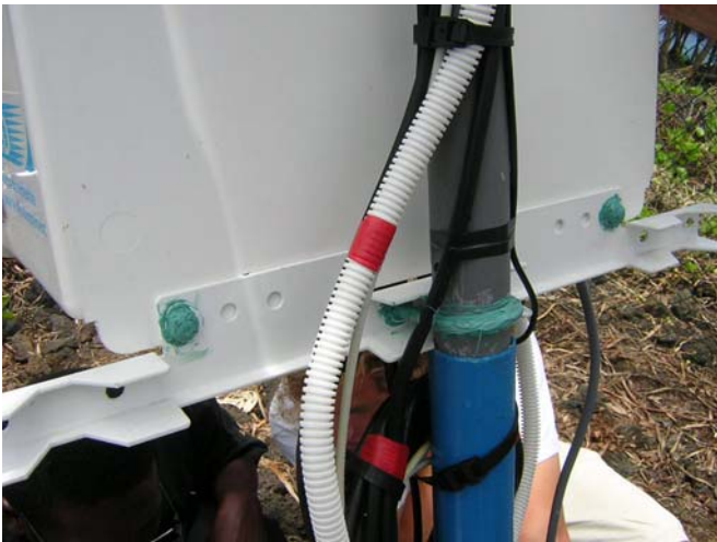
Photos 11 : Protection anti-corrosion placée à tous les endroits sensibles de la station météorologique (à gauche) et vue de l'ensemble du site de la station, avec le panneau de présentation (à droite).
