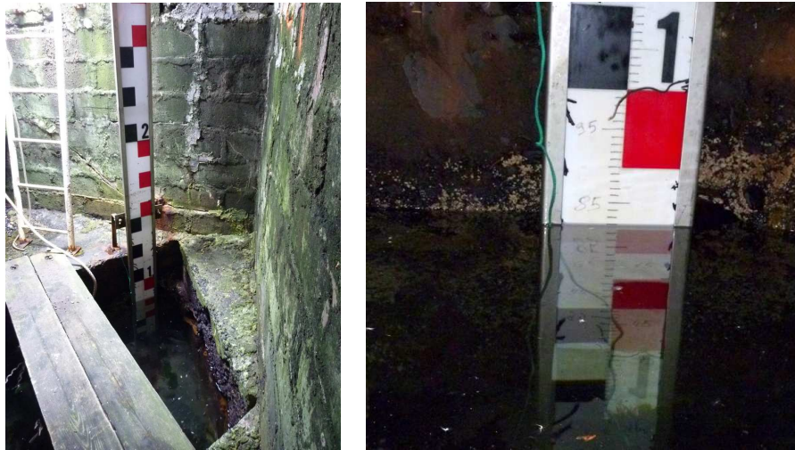
Figure 6 : L'intérieur du puits de l'échelle de marée à PAF.
