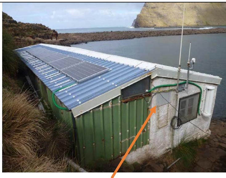
Pignon dégagé de l'ancien panneau solaire pour l'installation du mat support d'antennes de la future station SPA02
