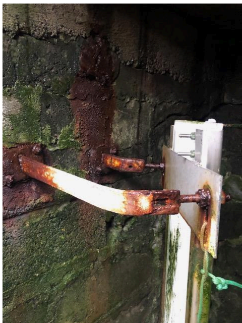
Figure 24 Les fixations de l'échelle sont oxydées mais solides
