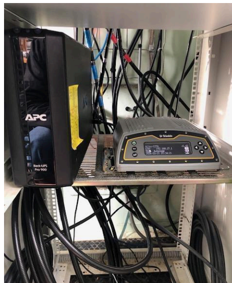
Figure 6 Récepteur CZTG et Onduleur
