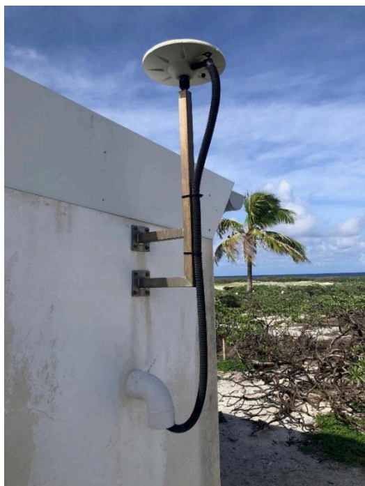
Figure 3 Ensemble mat et antenne en bon état
