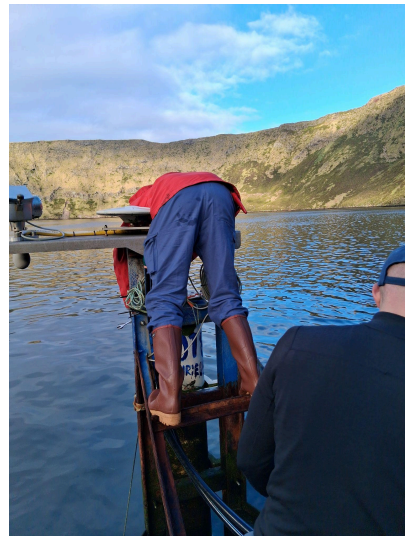
Figure 49 Actuellement pour accéder au marégraphe de pression il faut se pencher au-dessus de la structure en étant debout sur des cornières (non prévues pour) et avoir de l'aide d'autres opérateurs sur le côté en surplomb
