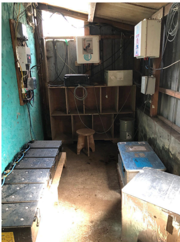
Figure 46 Intérieur de la cabane, SP1 à droite, SP2 au fond
