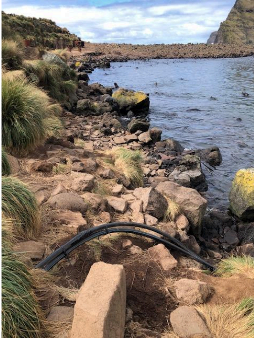
Figure 39 Épissure à terre
