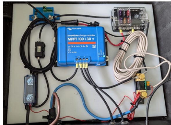
Figure 11 Schéma et installation de régulation solaire
