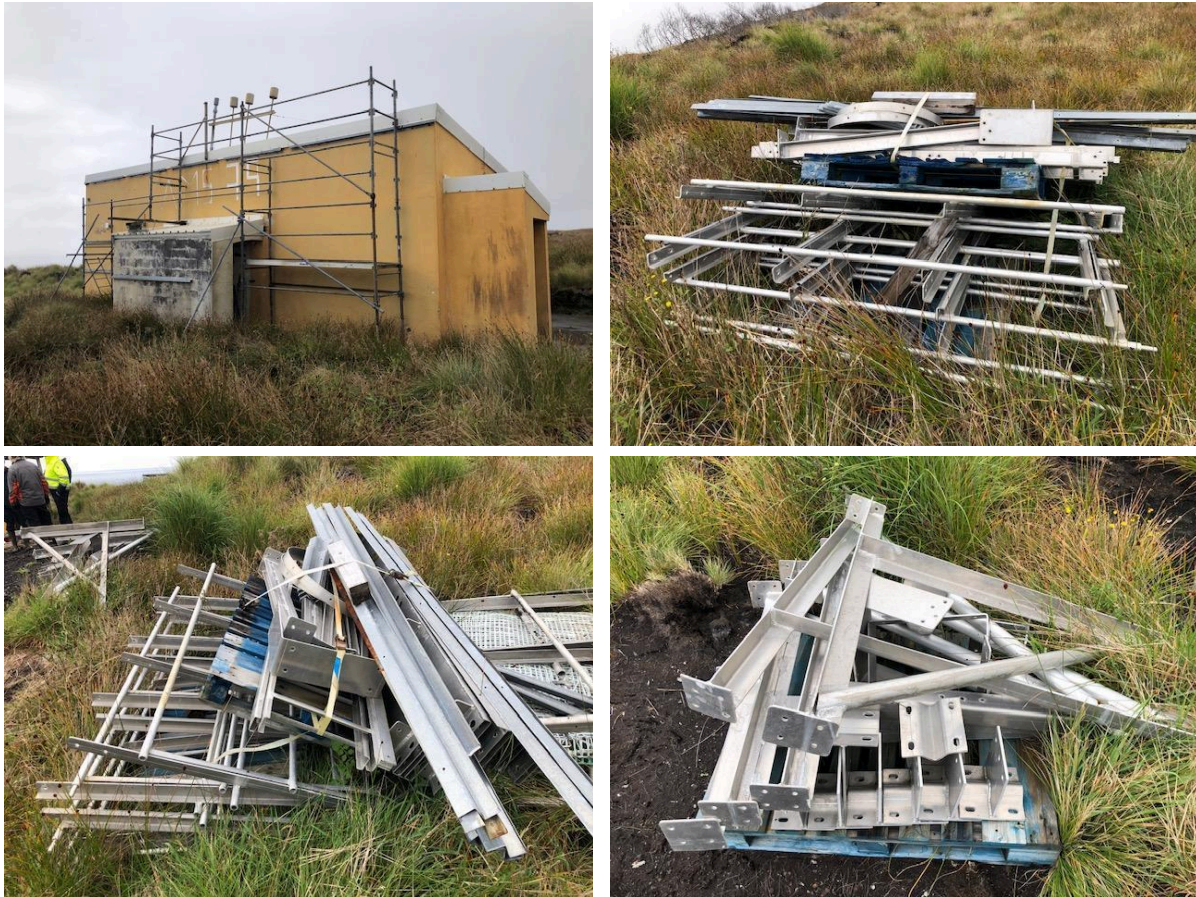
Figure 54 Etat actuel du bâtiment à Pointe B. et éléments en aluminium de la future passerelle stockés à proximité
