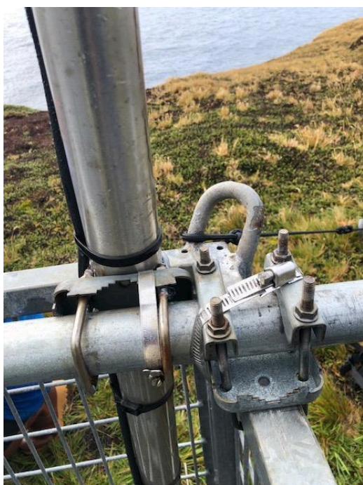
Figures 17 Détail des parties oxydées brossées et traitées
