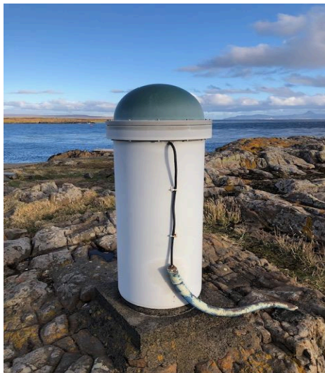
Figure 22 Le Pilier KETG est en bon état [un des portes collier du bas est à changer (vissé sur structure)]
