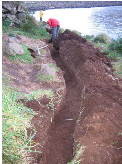
Tranchée entre la cabane et le puits du marégraphe
