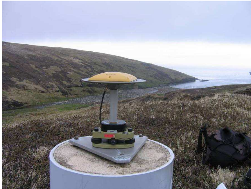
Antenne GPS sur le pilier NIVMER à Crozet
