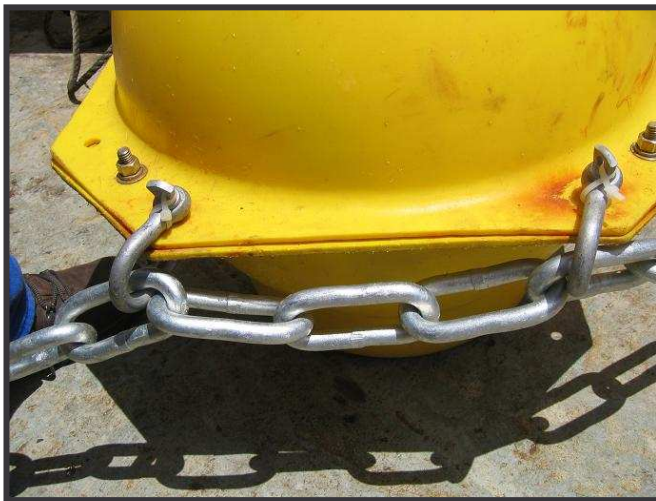
Figure 2: (a) Comment monter la chaîne de mouillage.
