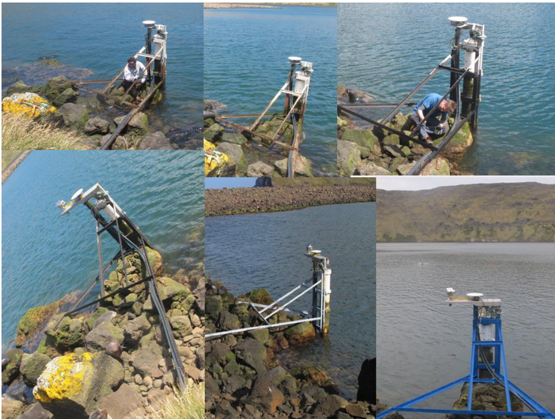
Figure 11 : Traitement de la structure du marégraphe (Piquage, anti-rouille, apprêt et couches finales)
