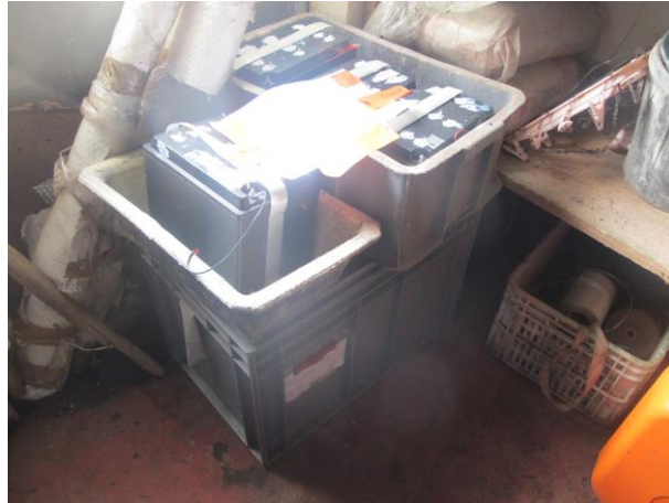
Figure 12 : Les vieilles batteries sont évacuées.
