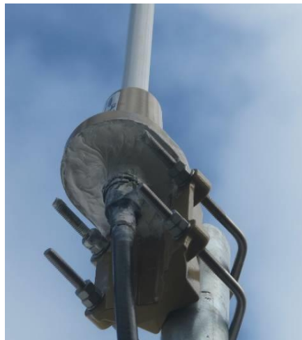
Figure 9 : Protection au mastic de la connexion ARGOS de SP02
