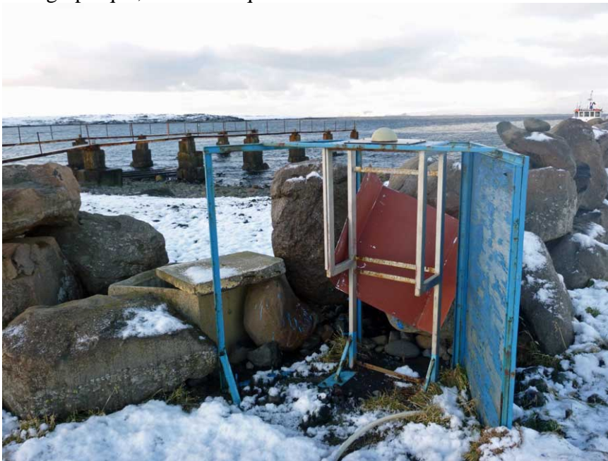
Ce qui reste de la station KER1 sous la neige
