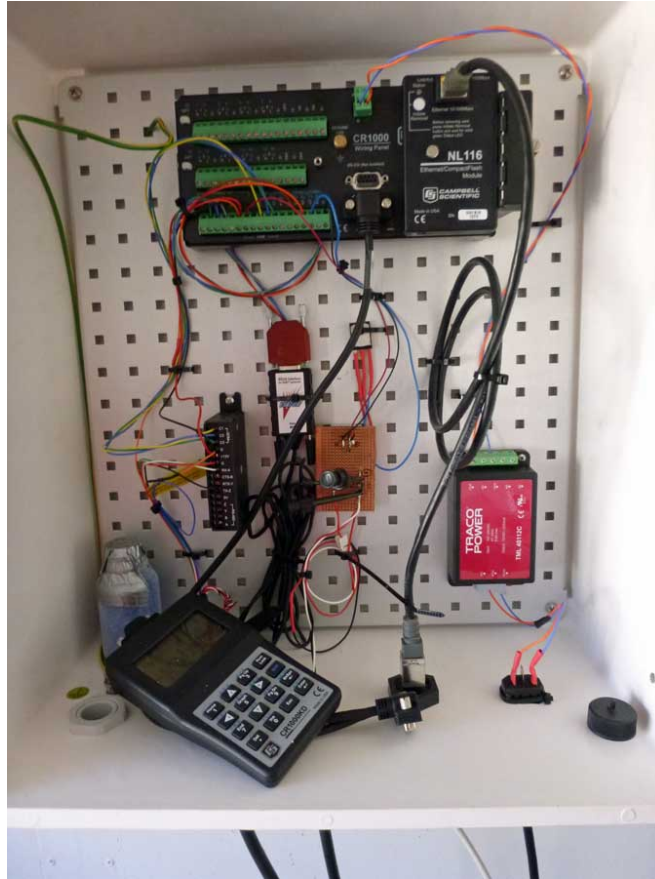
Intérieur de la Station KER3
