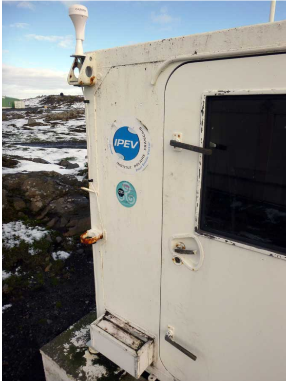
Passage du câble de l'antenne gps de KER3
