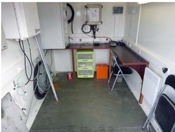
Intérieur du shelter
