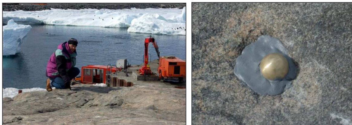
Figure 5: Installation du repère M
