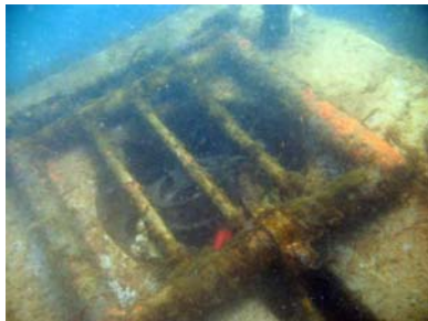
Grille de protection du marégraphe
