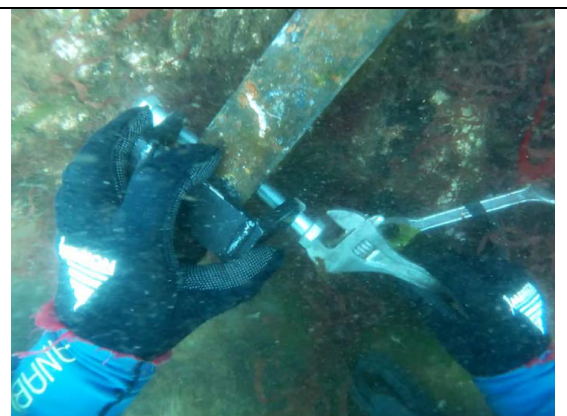
Mise en place des cavaliers 24/01/22
