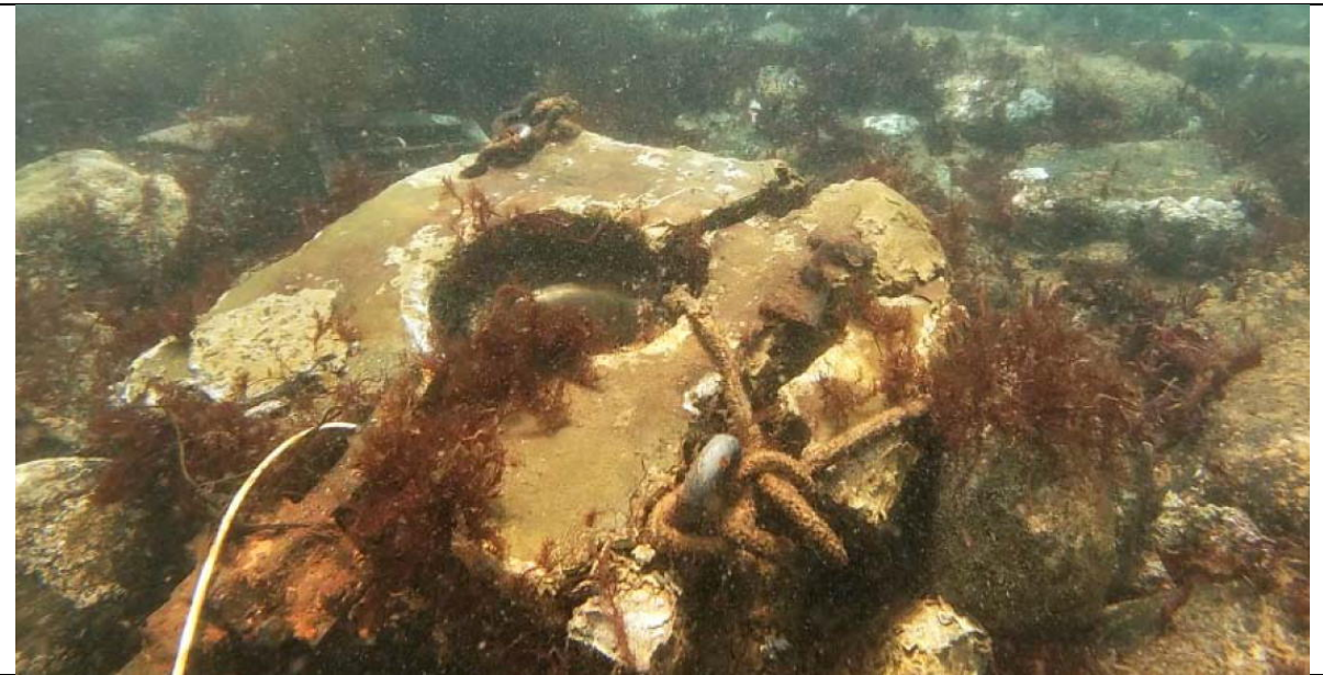
L'ancien bloc béton de 1m de côté détruit par un iceberg avec sa chemise en fibre (02/2019)
