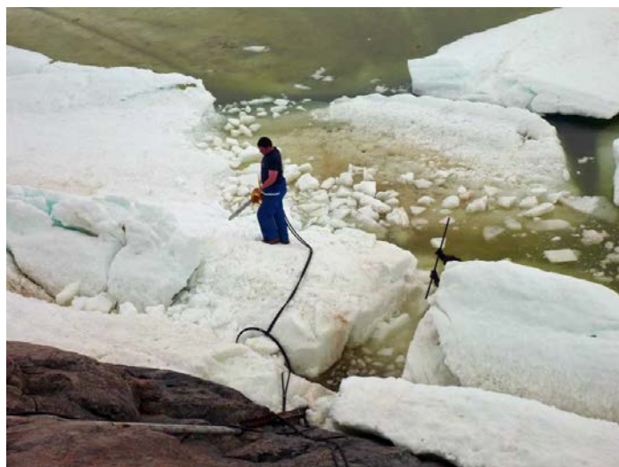
En prévision de notre arrivée prochaine, Erwan Esnault à la tronçonneuse et Antoine Schaad à la barre à mine dégagent le tube acier qui protège le câble du marégraphe au niveau de la banquette (photo : © G. Largouët IPEV)
