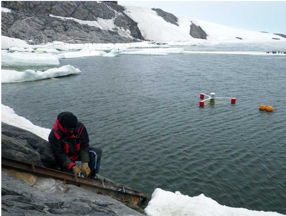
La poutre est dessoudée du tube qui protège le câble de la banquette.
