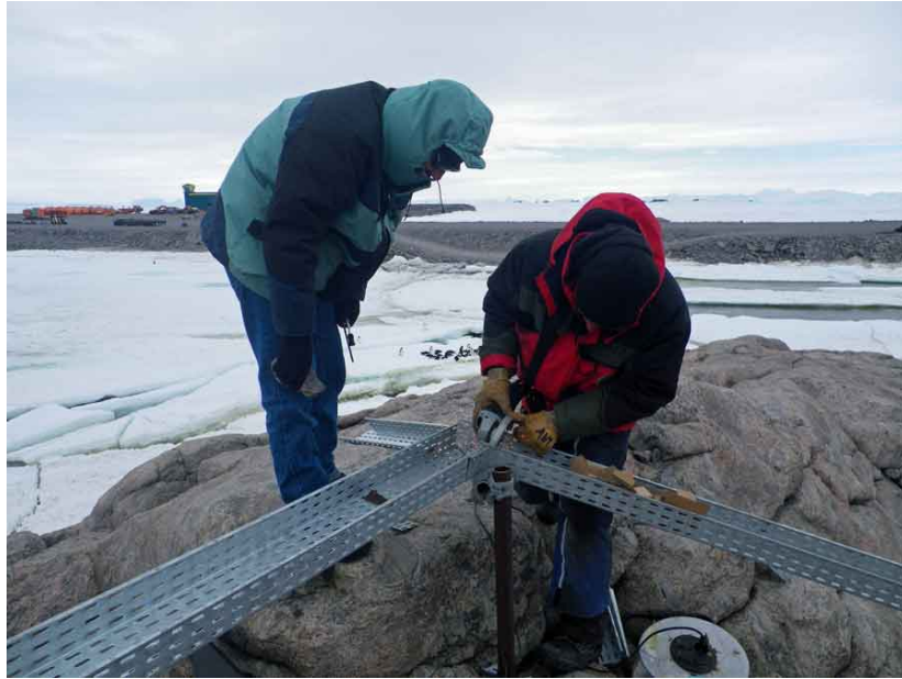
Coupe et pose du chemin de câble
