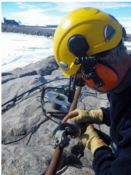
Tronçonnage des Tubes Mills pour le chemin de câble.
