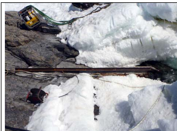
Mise en place de la cornière en U pour protéger le câble
