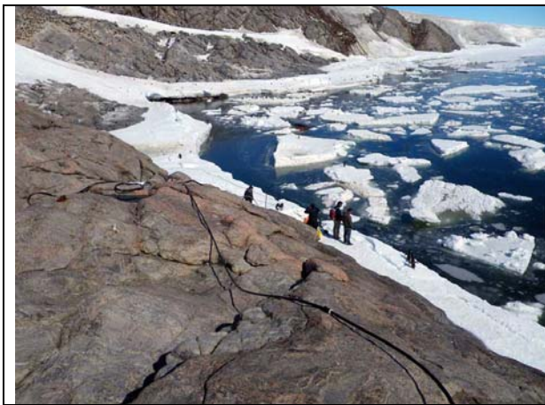
Passage du câble dans la gaine en PE et ses raccords
