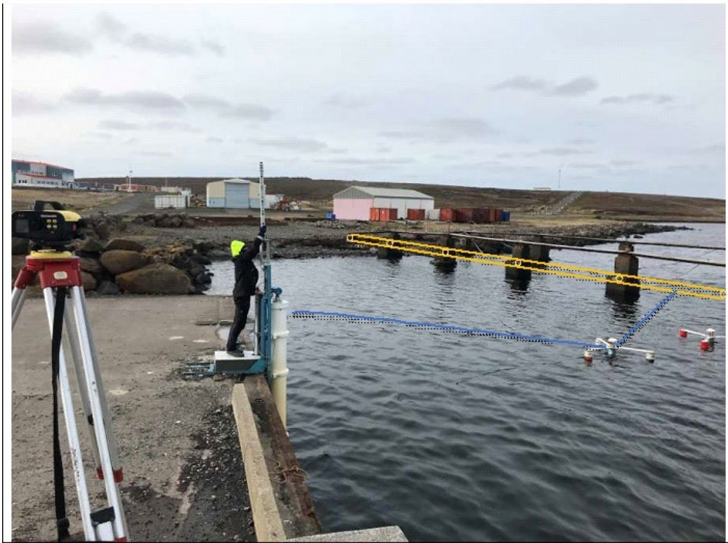
Nivellement et proposition de va et vient (en jaune) le long de la passerelle pour déployer la bouée GNSS
