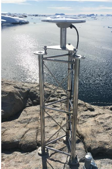
Figure 4 : Nouvelle antenne GNSS « DUMR »
