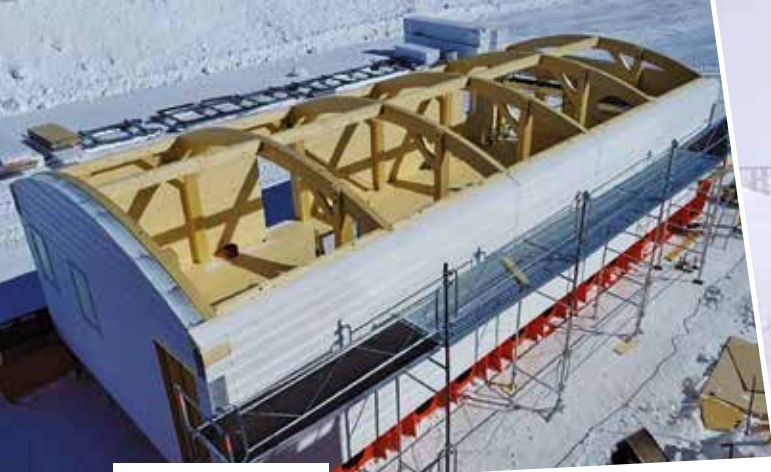
Vue d'ensemble du Modulo Bagno avant couverture. © P. Goicoetchea
