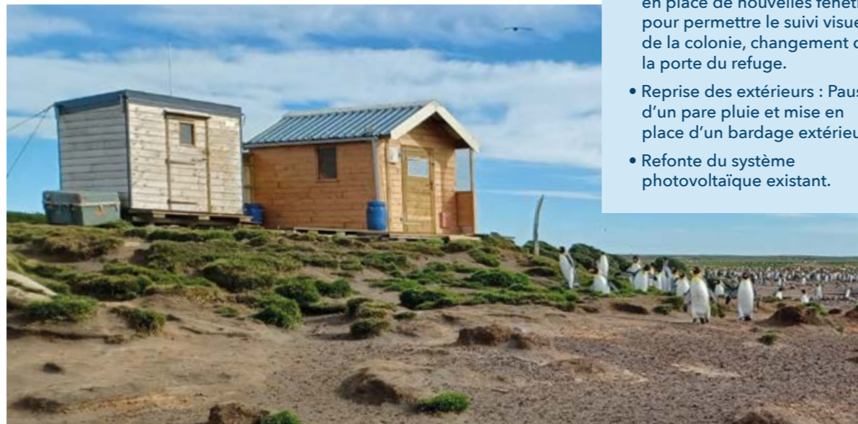
Le refuge du Guetteur après travaux
