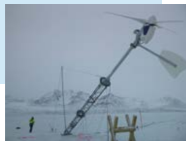
Réalisation des ancrages des haubans et relevage de l'ensemble mât et génératrice
