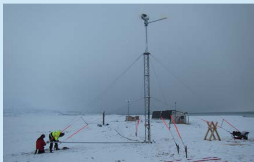
Réalisation des ancrages des haubans et relevage de l'ensemble mât et génératrice
