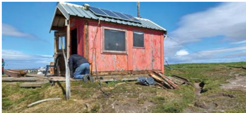
Le refuge du Guetteur avant travaux
