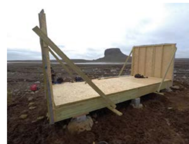
Construction du nouveau refuge Campbell
