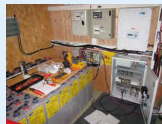
Modification de l'installation électrique de la station Corbel
