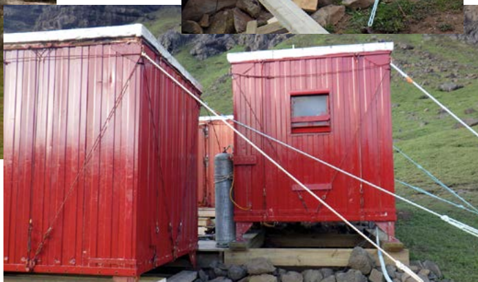
Réhabilitation du radier au refuge de Studer.
