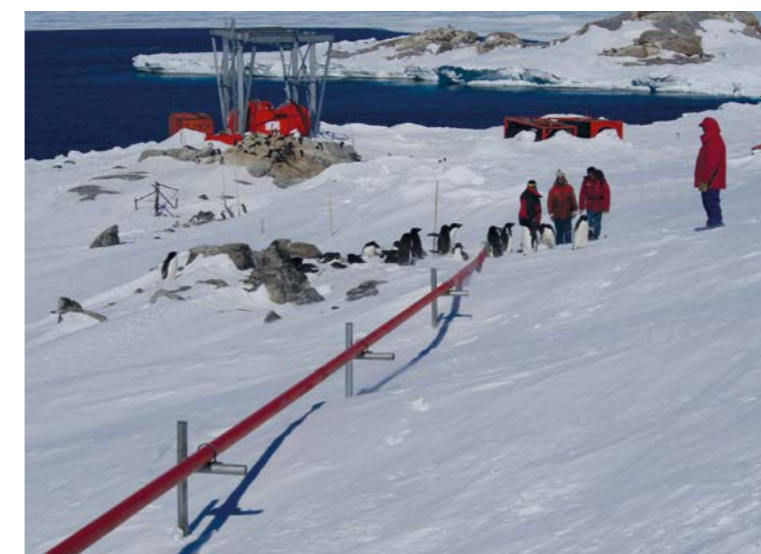
Achèvement de la pose et des raccordements sur la conduite de gasoil
