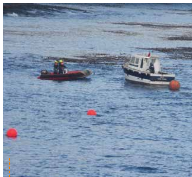
Figure 8 - Préparation de la récupération d'un des anciens câbles présents dans la Baie du Marin. Les bouées soutiennent un câble en acier qui est attaché à l'ancien câble par une équipe de plongeurs sous-marins.
