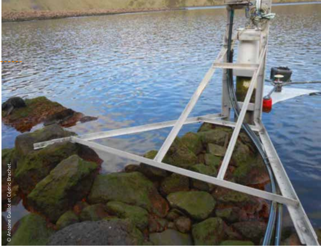
Figure 10 Photographie du marégraphe de Saint-Paul.
