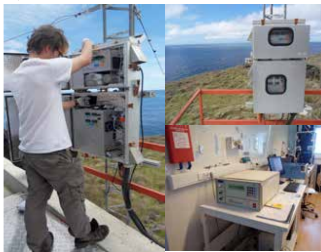
Vue d'une partie des instruments en extérieur et de leur maintenance par les hivernants sur place.
