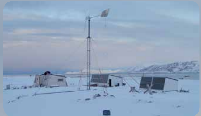
b : Après réfection et développement des énergies renouvelables
