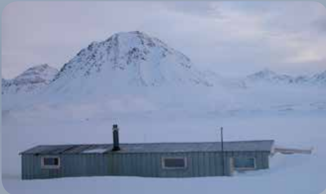
a : Avant réfection
