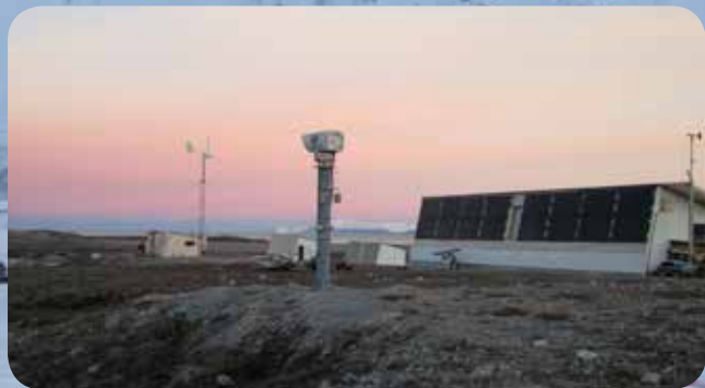
Pont réseau Corbel
