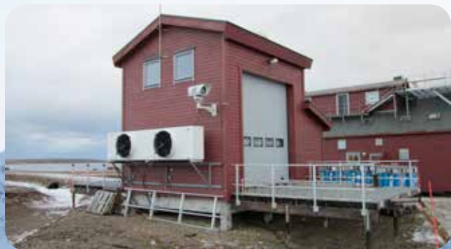
Pont réseau Ny-Ålesund
