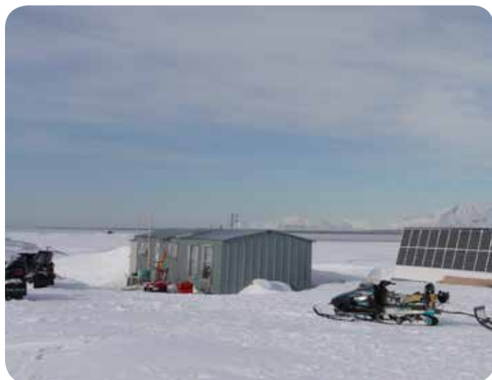
Bâtiment A avant rénovation
