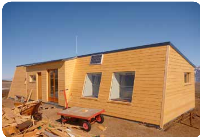
Bâtiment A après rénovation
