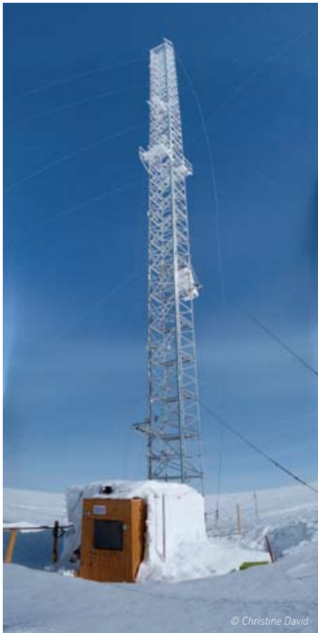
La « Tour Américaine » à Concordia : tour instrumentée de 45 m de haut, portant notamment des équipements de suivi à long terme des paramètres atmosphériques dans le cadre du programme observatoire GLACIOCLIM (+ CALVA)
