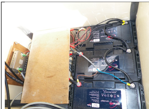
Les 3 batteries sont mises an parallèles avec des câbles qui y sont vissés (vis fendues)
