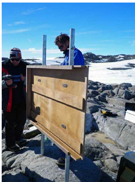
Le cadre en bois des panneaux solaires est fixé sur les tubes Mils.
