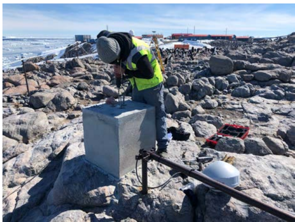
Mise en place du support d'antenne.
