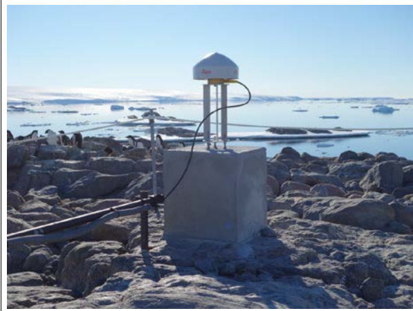
Antenne GNSS « DUM2 »
