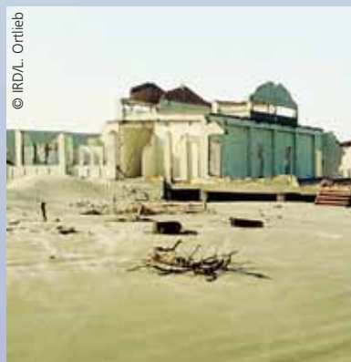
Dommages subis par les édifices construits sur le haut d'une plage au Nord-Pérou, lors de l'événement El Niño de très forte intensité de 1982-83.
