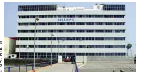
Bâtiment principal de l'Institut de la mer du Pérou (Imarpe).
