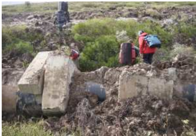
Figure 3. Ligne de gazoduc dans la région de Pangody, affectée par les processus de thermokarst.
